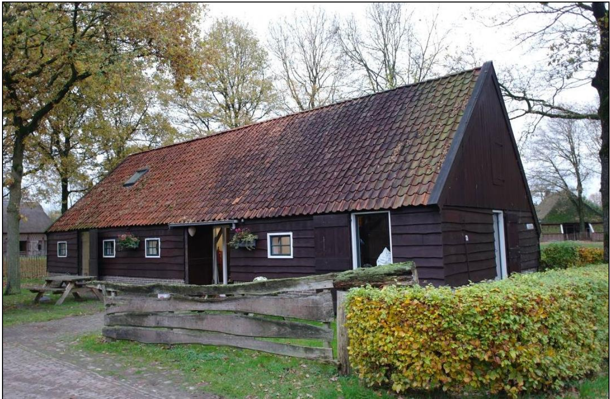
Voorzijde Nieuwe Tingieterij
